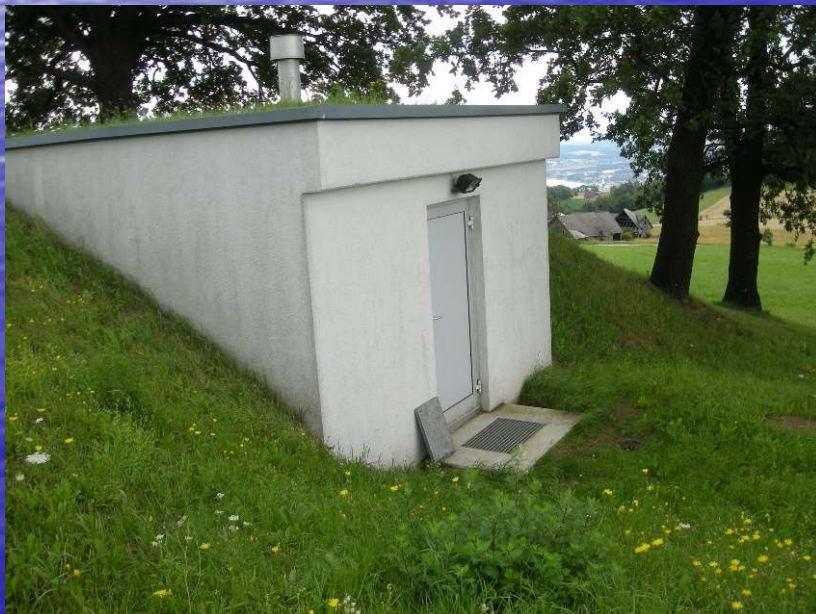
Hochbehälter Eben alt 200 m 3
