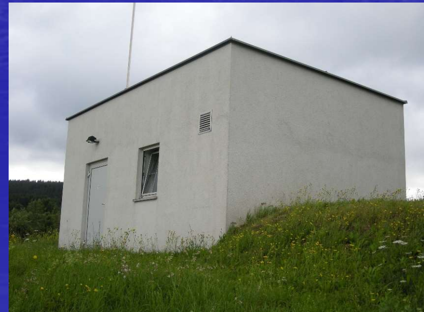
Hochbehälter Eben neu 350 m 3
