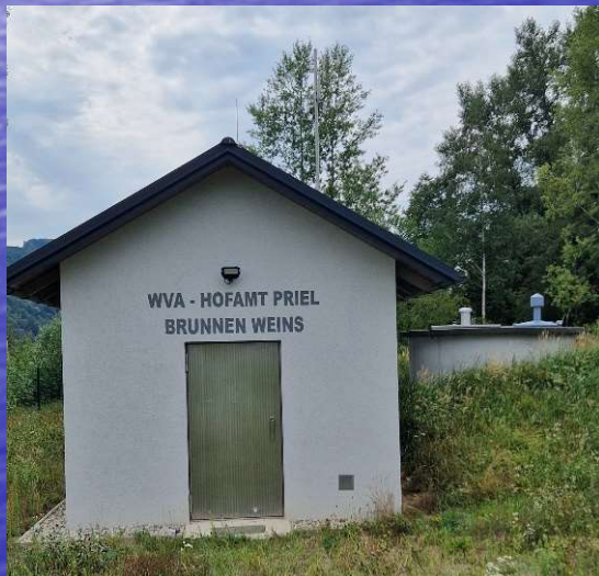
Brunnen Weins Betriebsgebäude
