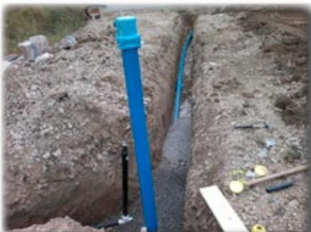
Die Wasserleitung wurde im Zuge des Feuerwehrhausbau umgelegt
