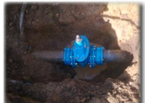
Ein zusätzlicher Streckenschieber wurde in Am Reitern eingebaut.
